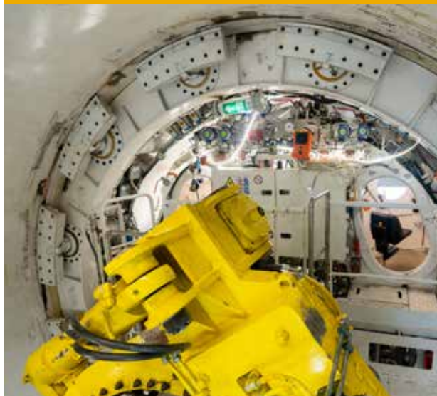
L'intérieur du tunnelier de la Connexion ligne B
